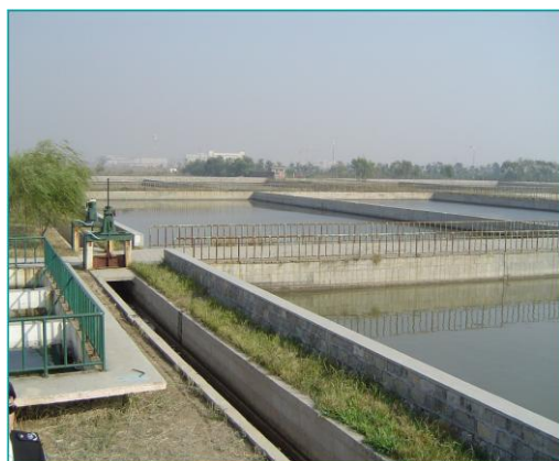
图 36 合兼性塘（塘底与污泥发酵坑、塘中有填料）
