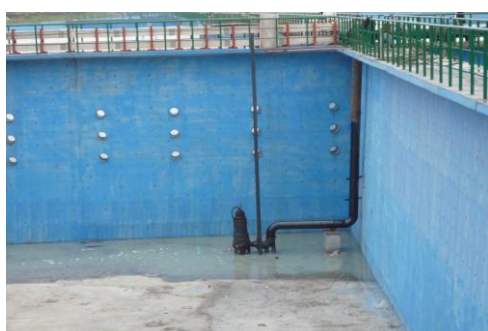
图 45 沉淀塘及其中的污泥回流泵
