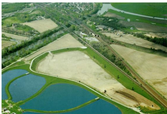
A: 接纳雨水径流时照片
