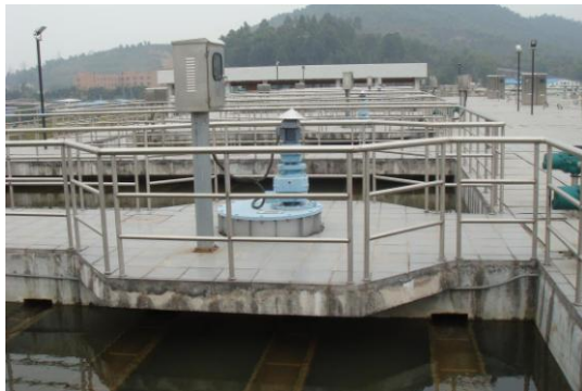
图 A：混凝-絮凝-斜管沉淀池
