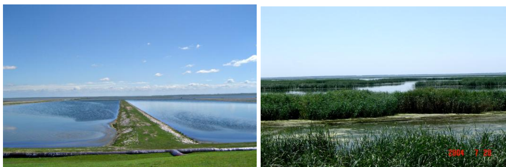
图 32 青肯泡石化废水处理生态塘厌氧塘 图 33 青肯泡石化废水处理生态塘湿地 最终排放口处的出水水质可达到 COD 38.4~103.4 mg/L，SS 10~79.24 mg/L，BOD 5 3.13~8.6mg/L，氨氮 2.8~14 mg/L，苯酚 0.003~0.01mg/L，硫化物<0.01
