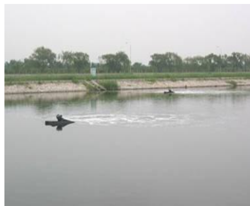
图 36 合兼性塘（塘底与污泥发酵坑、塘中有填料）
