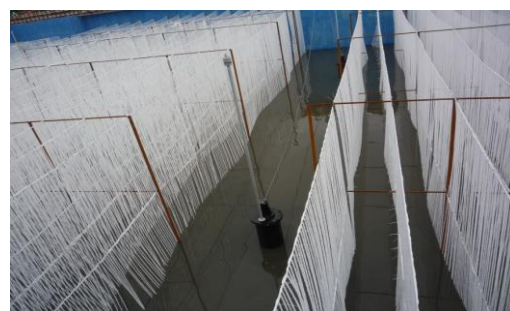
图 44 复合曝气塘中的填料与曝气机
